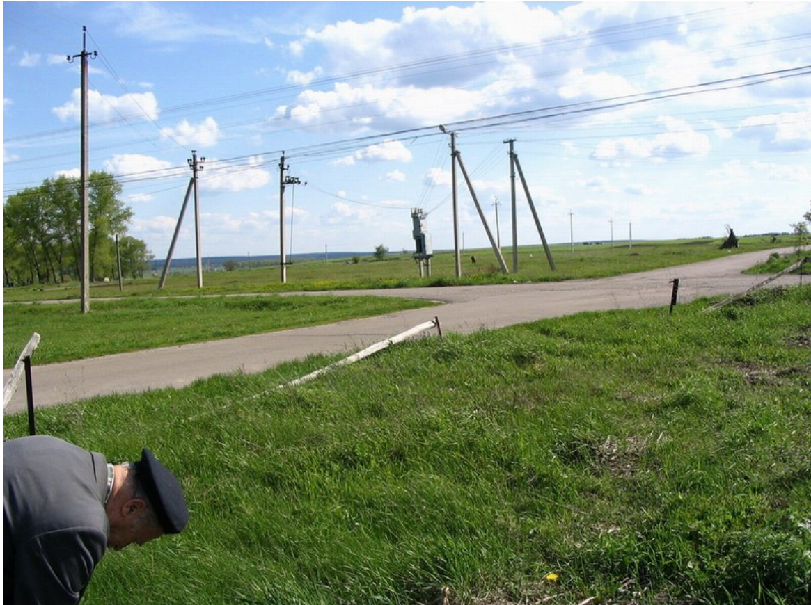
Рис.7 Лінії електропередач та трансформаторна підстанція поблизу точки зависання НЛО
